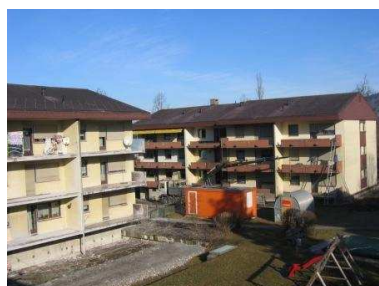
WHA Fussenau während Sanierung 2008 Quelle: VOGEWOSI
